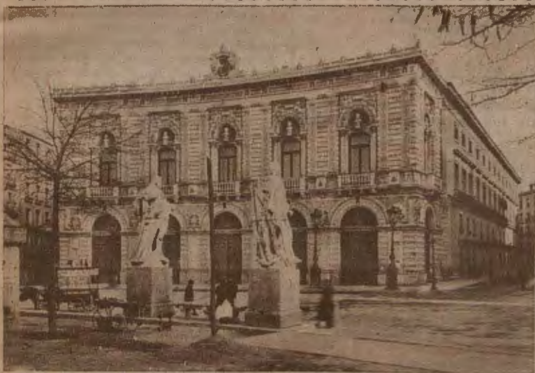
Fachada principal del Teatro Real, de Madrid, antes de las reformas que actualmente se efectúan en él
