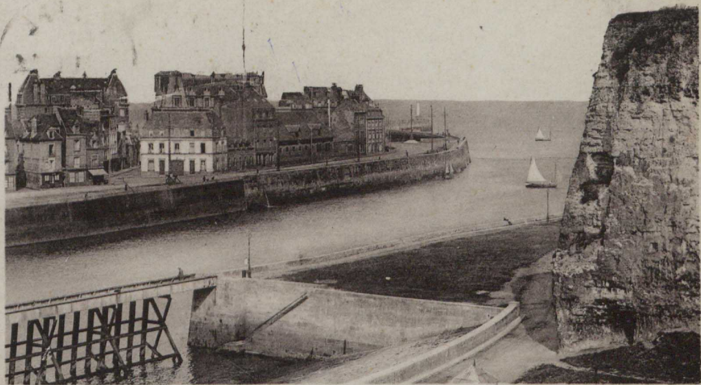
157 DIEPPE. — L'Entrée du Port — LI.
