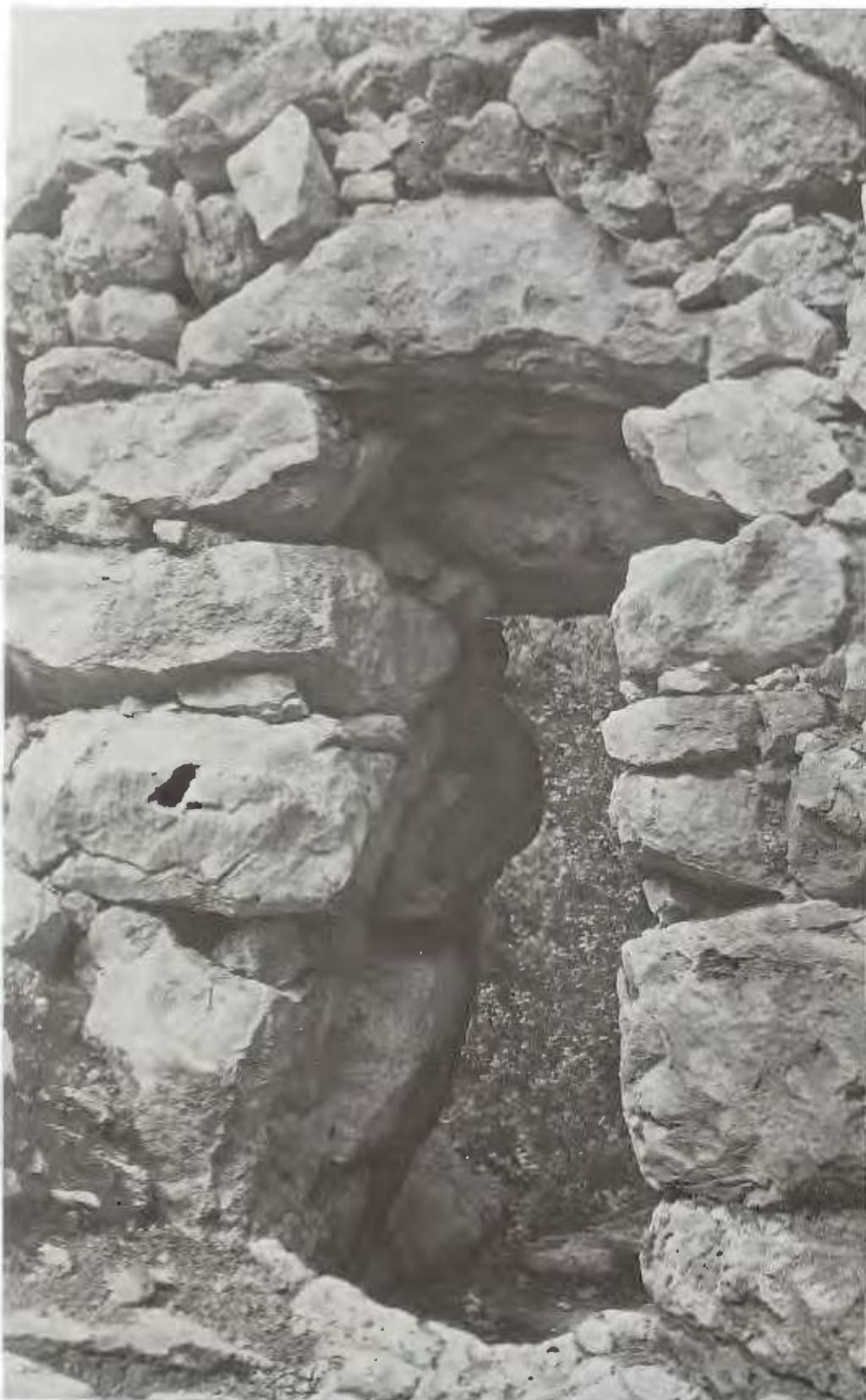
lumna central o sin ella y cubierta, que de momento no puede ser determinada con exactitud. Al parecer, utilizaron diversos sistemas: a base de techos de piedra sostenidos por troncos o lajas, o siguiendo la falsa bóveda, ya una cubierta adintelada sostenida por una gran losa, si bien este sistema no pudo ser comprobado (fig. 10).
