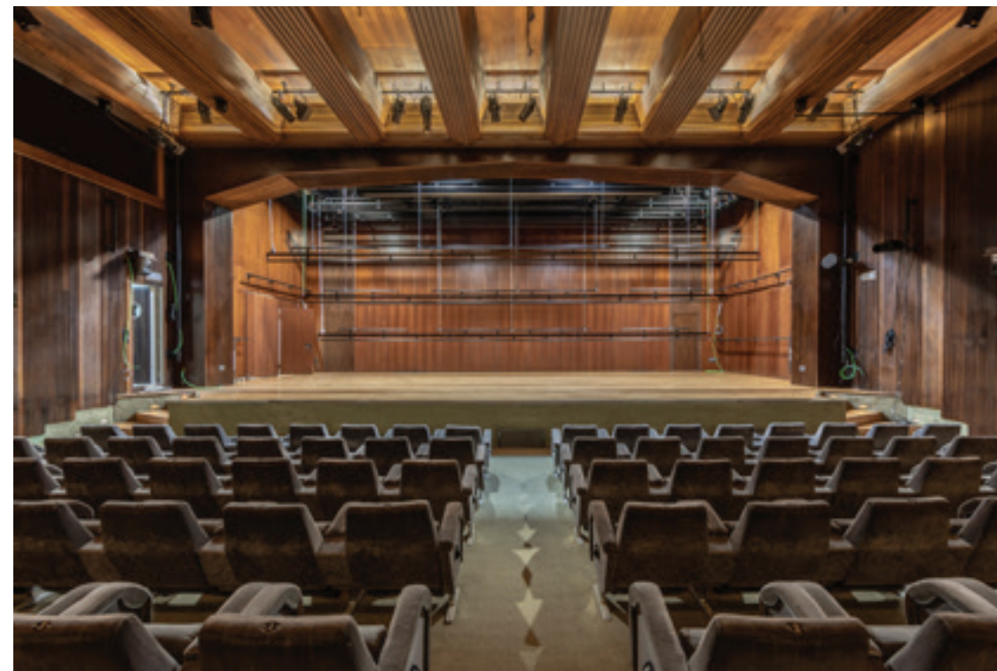
La nueva caja escénica con las barras motorizadas bajadas, antes de colocarse los focos y la microfónica
