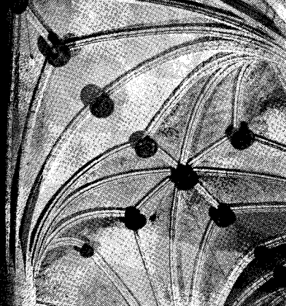
Bóvedas de la iglesia de San Vicente, Vitoria.
