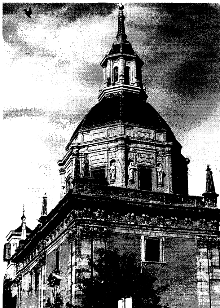
Muros y cúpula de la capilla de San Isidro, en la iglesia de San Andrés.
