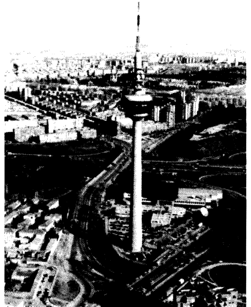
Torre de Comunicaciones de RTVE, junto a la M-30.
