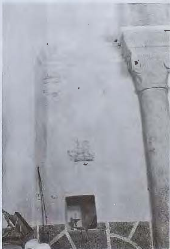
(Izquierda): Tramo recto del ábside antes del descubrimiento de las pinturas. Lado del Evangelio.—(Derecha): Tramo recto del ábside antes del descubrimiento de las pinturas. Lado de la Epístola.
