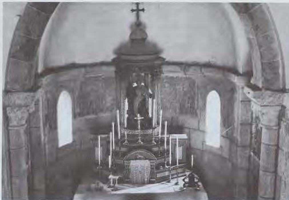
Vista del interior del ábside una vez concluidas las obras de restauración del templo.
