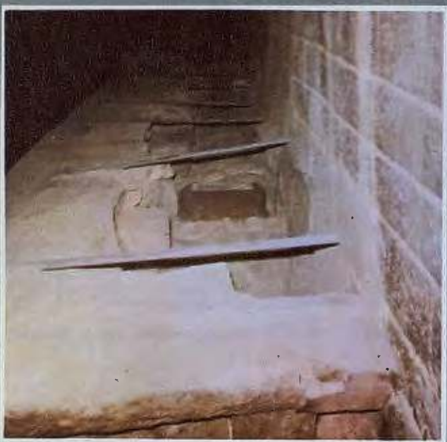
Aspecto general de la parte superior del trasdosado tras eliminar el relleno.
