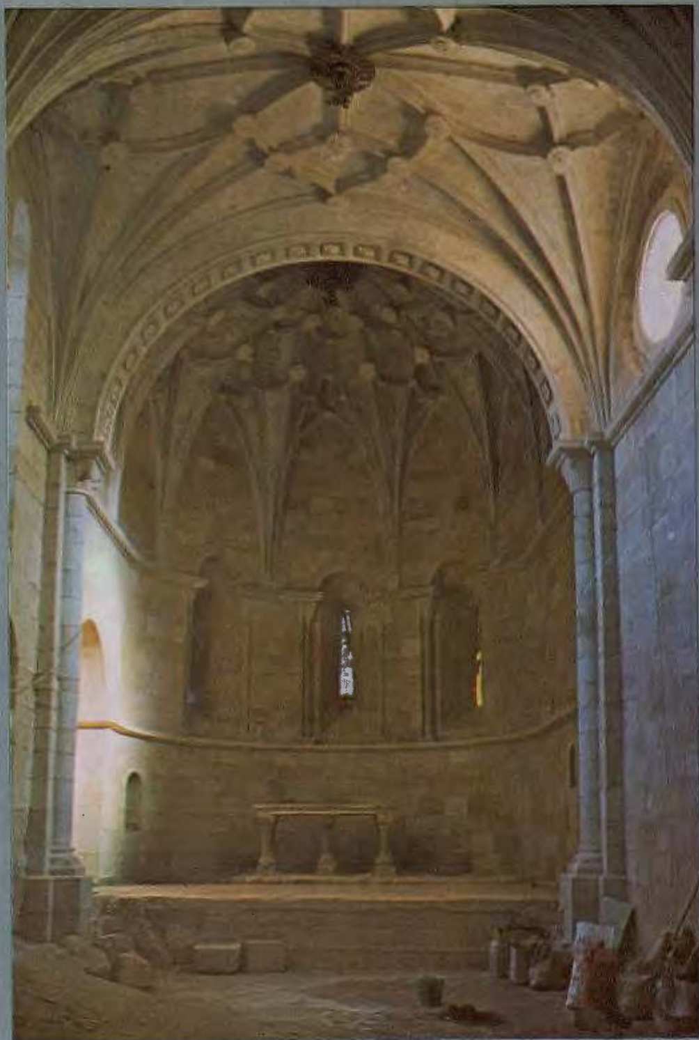
Parte anterior de la nave restaurada, con la formidable bóveda del siglo XVI.
