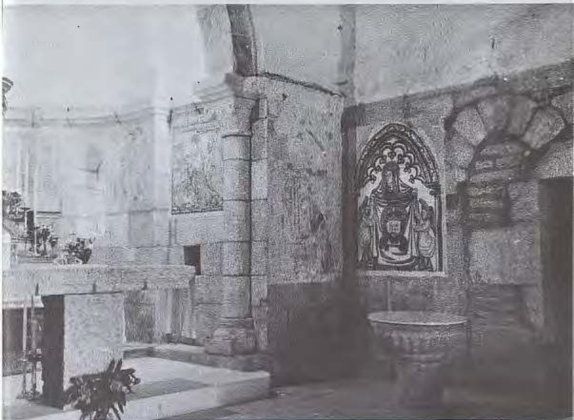
Conjunto formado por la cabecera y la nave en el lado de la Epístola, después de finalizada la restauración.
