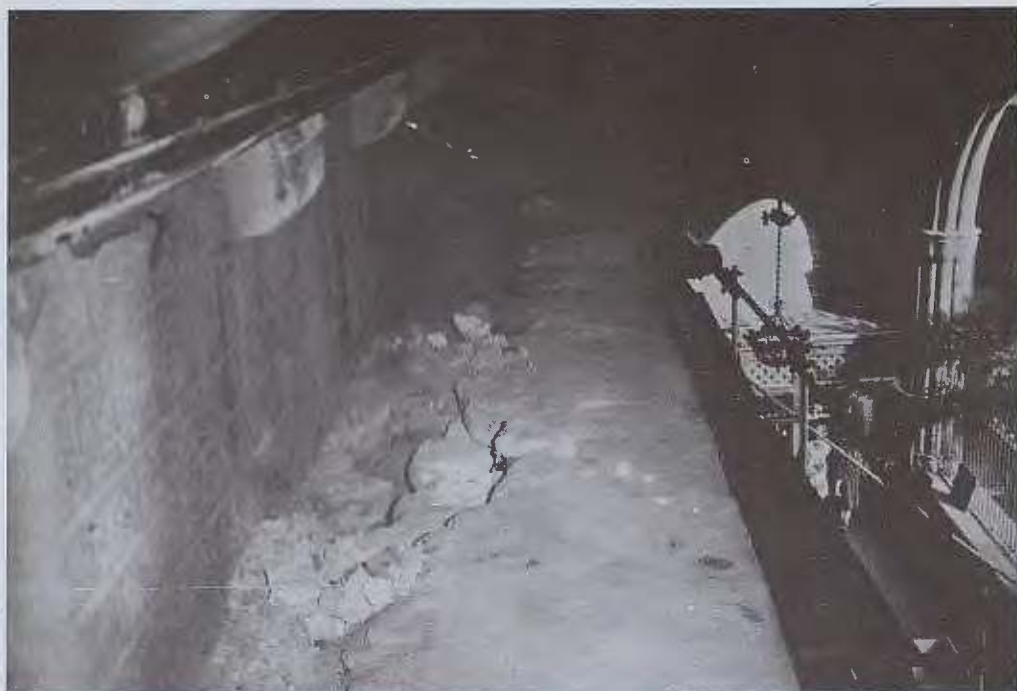
Aspecto general del relleno de escombros en la parte superior de la Portada.
