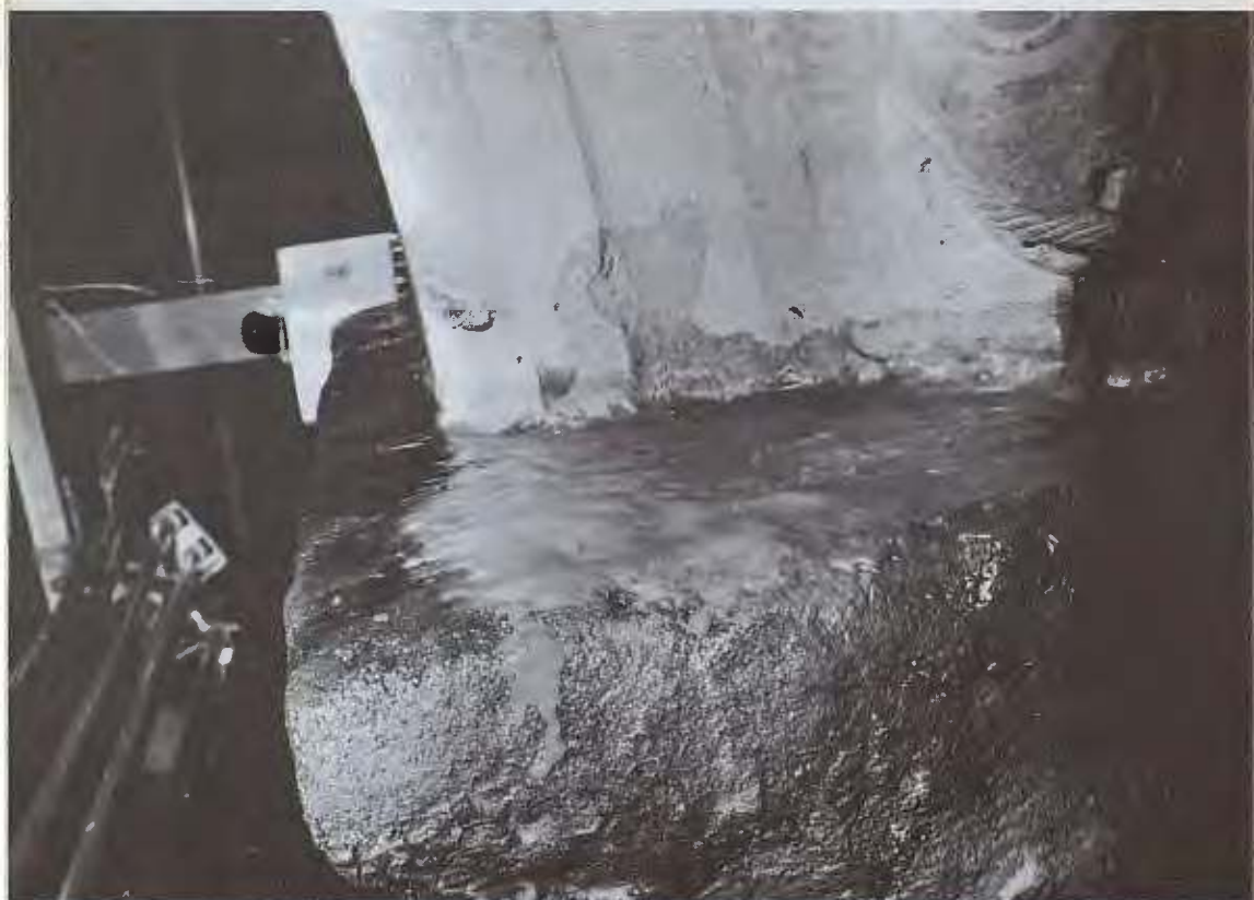
Aspecto general del tratamiento con rayos Infrarrojos y detalle de la aplicación de cera de abejas sobre la piedra caliente. Se observa el frente de cera líquida e indica aproximadamente la penetración alcanzada.
