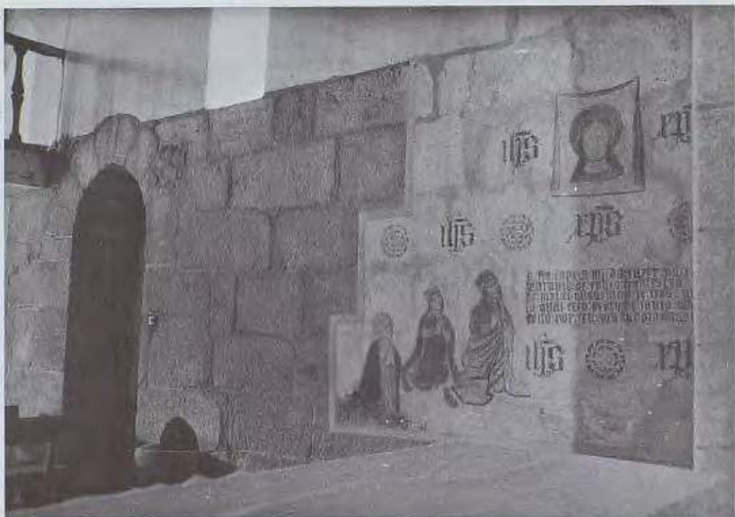
Detalle del muro y pinturas del lateral izquierdo.
