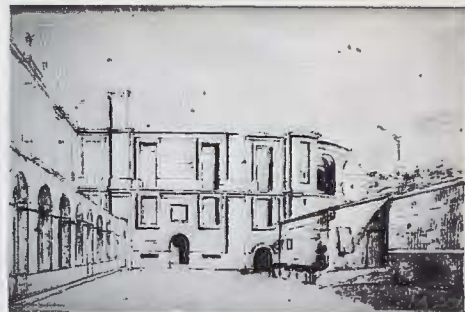
El exterior de la Sala de la Reina Isabel, en obras, hacia 1850.
